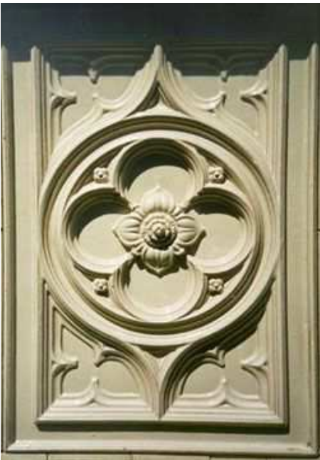
Pièce en céramique sur la façade
