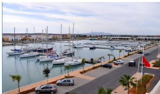
Figure 25 Le port de plaisance
