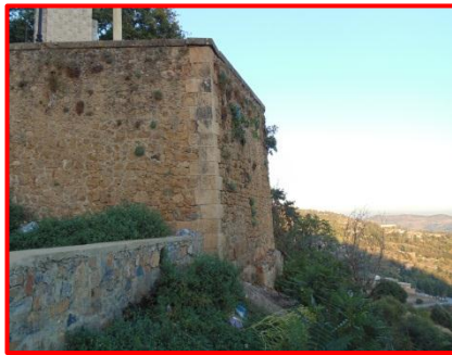
Figure 70 : partie sud de l'enceinte
