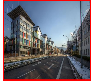
Figure18 : vue sur les bâtiments
