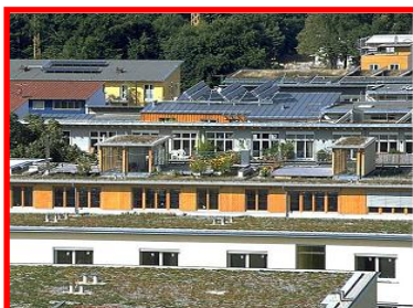
Figure16 : Vue sur les toitures
