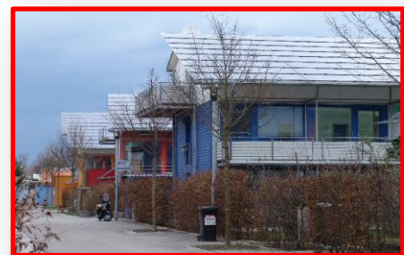
Figure 25 : toiture en panneaux solaires
