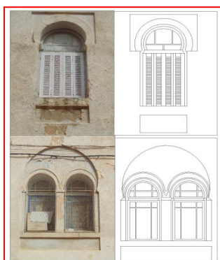
Figure 104 : Fenêtre de la mosquée
