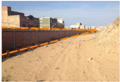
MUR DE CLOTURE
