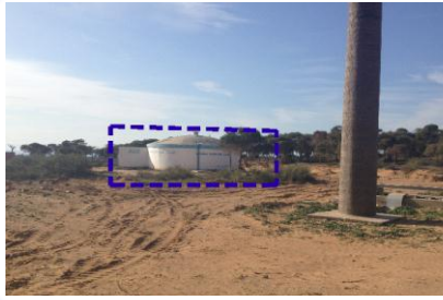
UN RESERVOIR D'EAU
