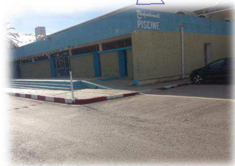
Vue sur la piscine
