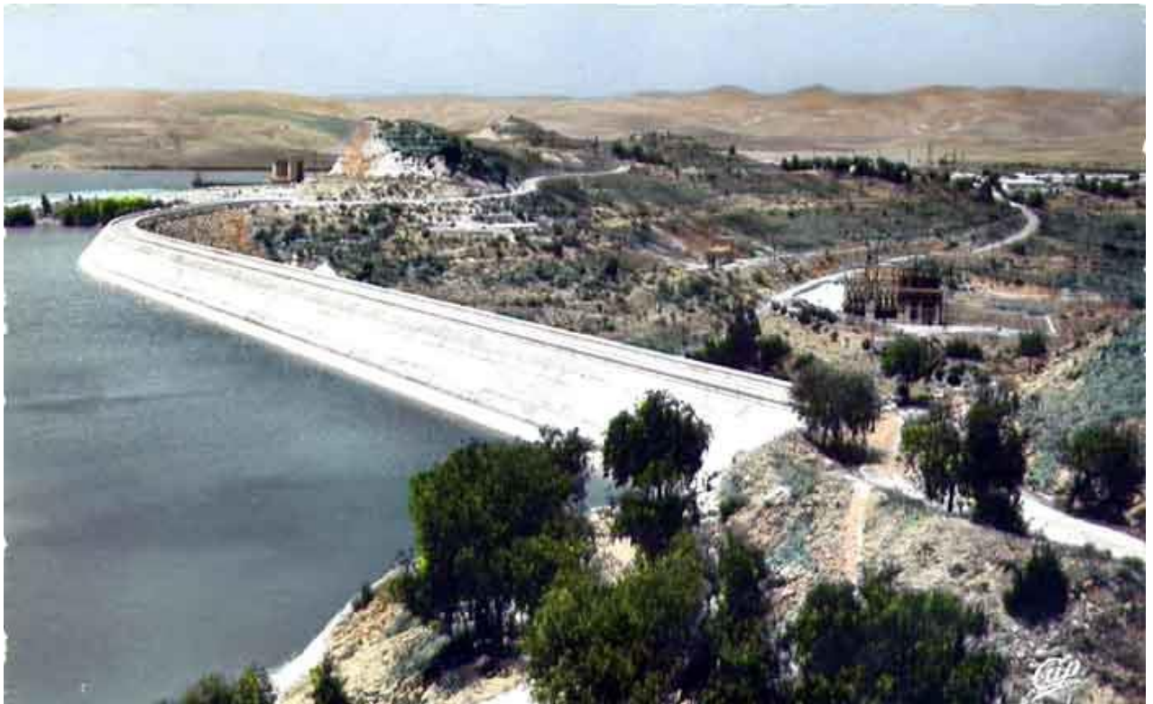
Figure 12 : le barrage de Bouhanifia
