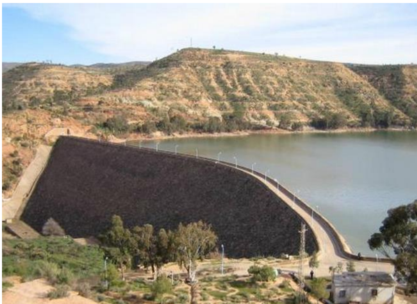
Figure 20 : le barrage de Bouhanifia
