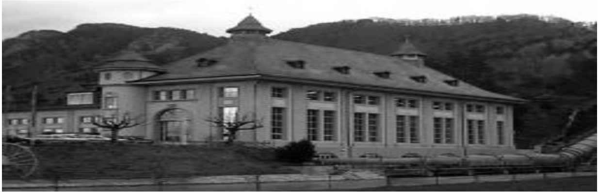
Figure 28: Electrobroc une centrale hydroélectrique en activité Suisse.
