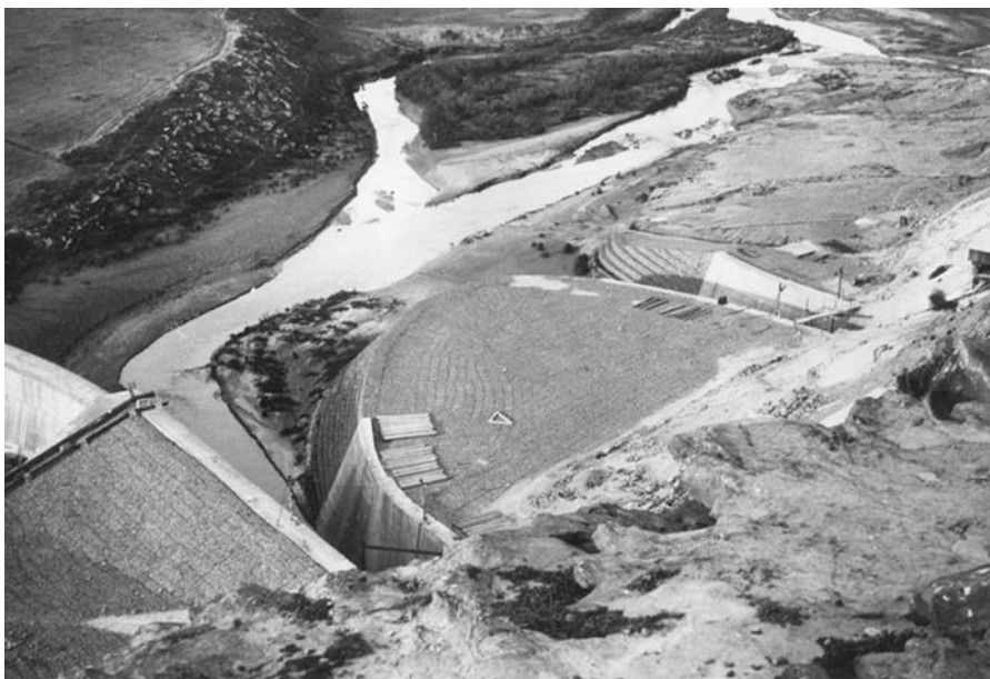
Figure 23 : barrage de Bouhanifia batardeau amont et les deux galeries séparées par une large mole 18/01/1939.
