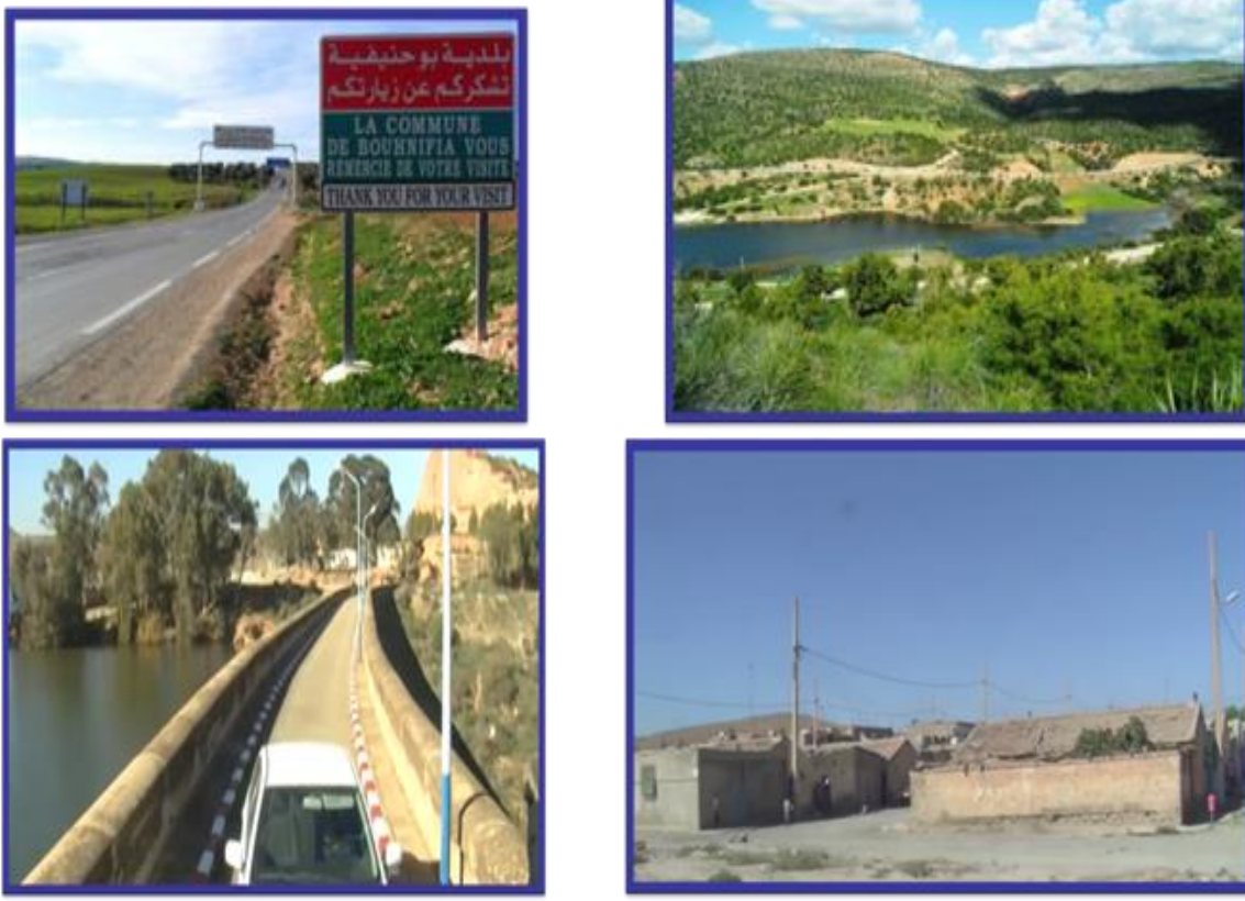
Figure 52 : différentes vues sur le perimètre du barrage de bouhanifia.
