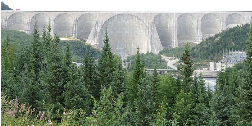
Figure 3 : barrage multi voûtes
