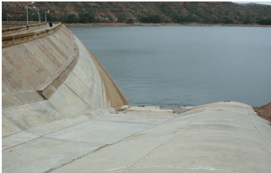
Figure 21 : vue sur la chute du barrage Bouhanifia.
