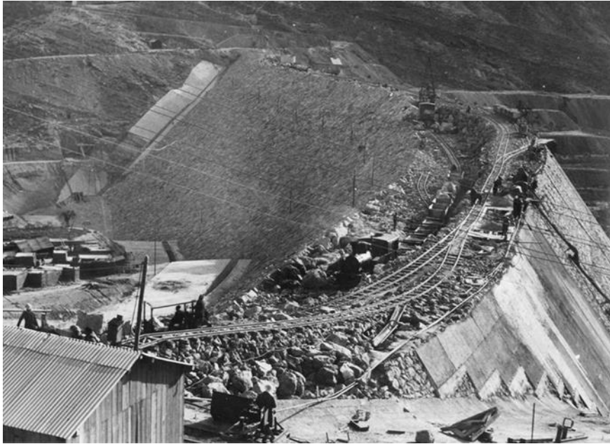
Figure 24 : barrage de Bouhanifia le 18/01/1939.
