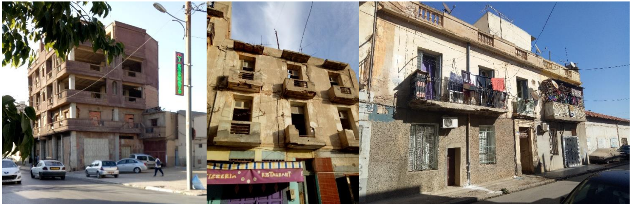
33 prises de vues sur l'état des habitation (collectif/individuelle).
