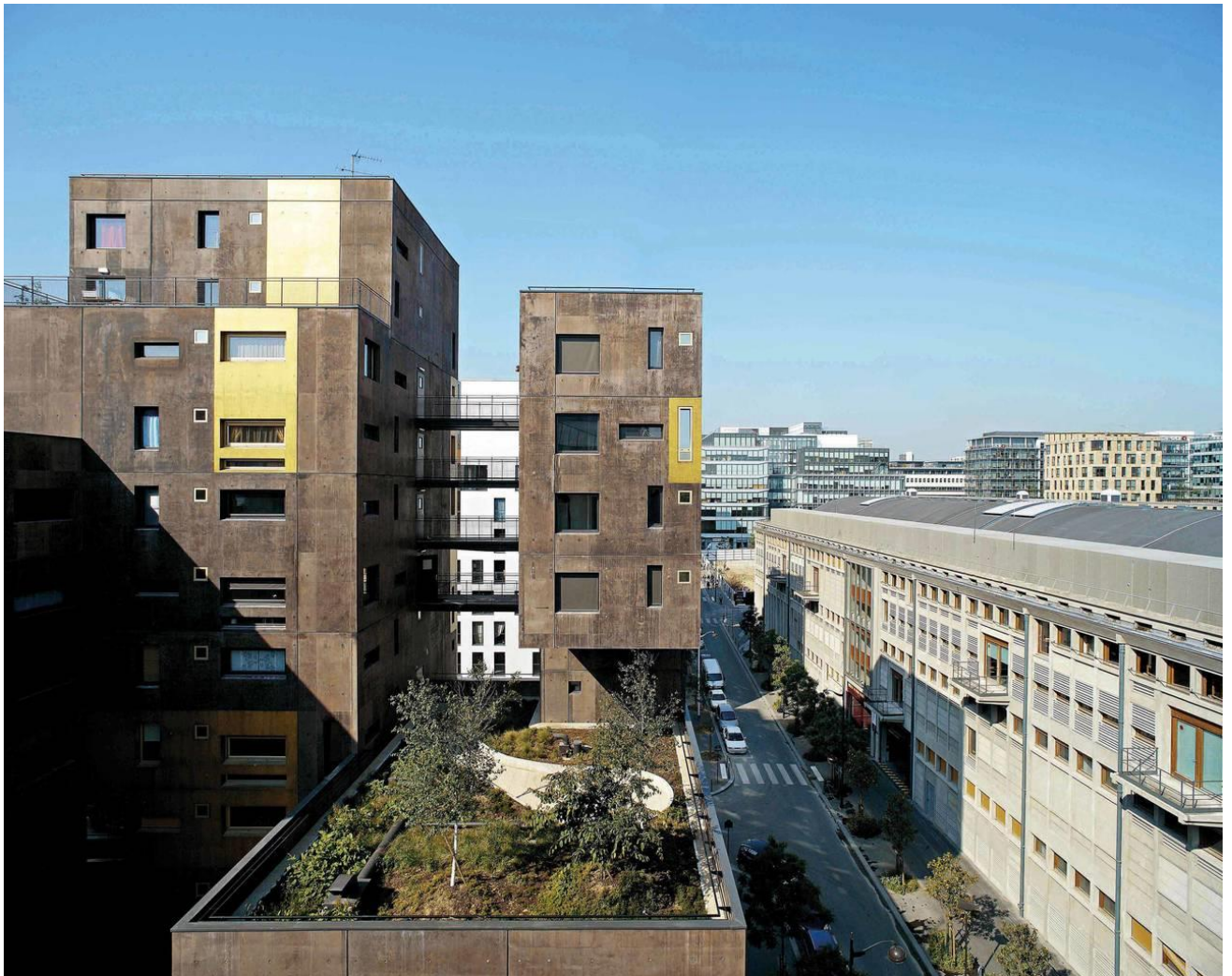
48 Fractionnement du volume de l'immeuble pour laisser pénétrer la lumière au cœur de l'îlot, Photo Quartier Massena grand Moulin.
