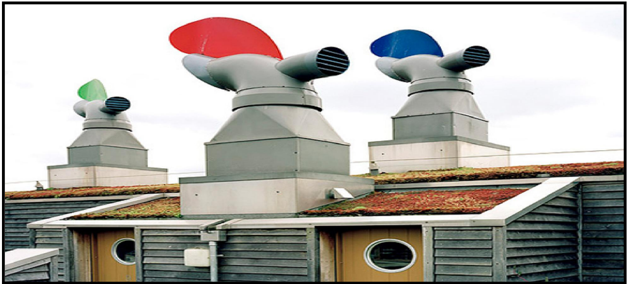
Figure n20: Les éléments d'aération à la toiture :
