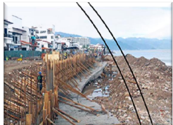
Figure82:lemur de soutènementencours de réalisationSource:Archidaily
