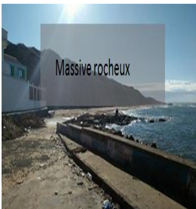
Figure154:photo de constat Source Auteur 2018
