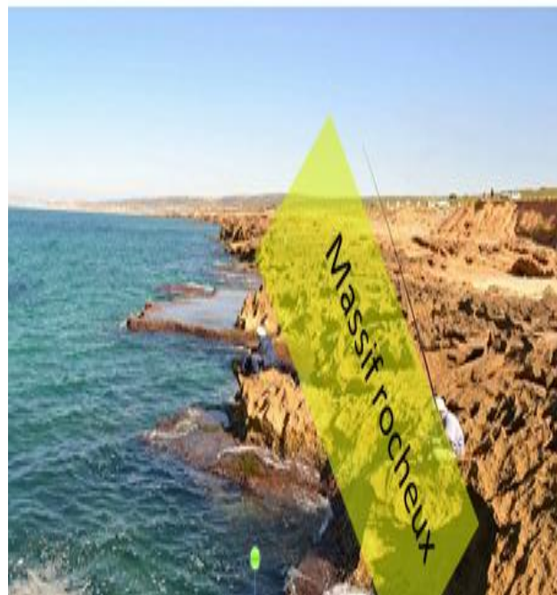
Figure153:photo de constat Source Auteur 2018
