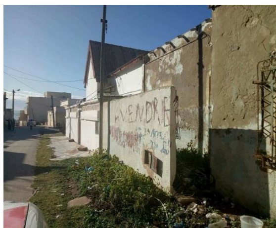
Figure169: photo de l'état de bâtis Source: Auteur
