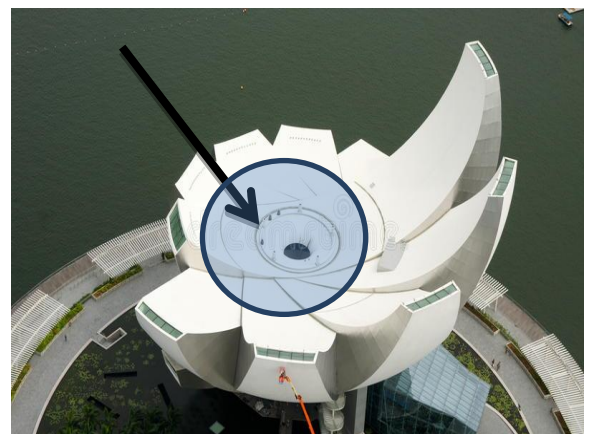
Figure48: Vueaerienne montre la canalisation de l'eauSource :Archidaily
