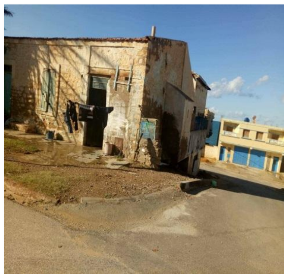
Figure145:photo d'une habitation achevée
