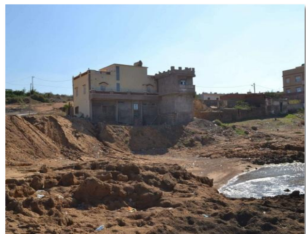
Figure 173: Etat des Hauteurs Source: Auteur
