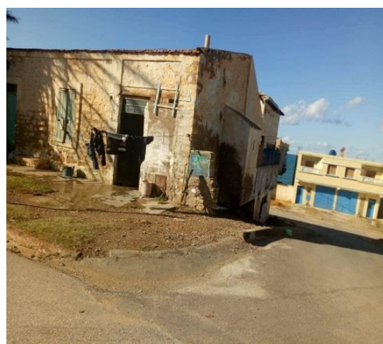
Figure170: photo de l'état de bâtis Source: Auteur
