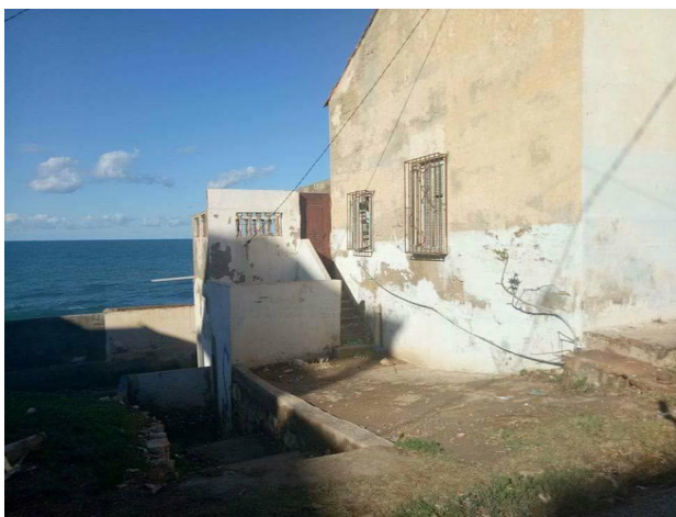
Figure 172: Etat des Hauteurs Source: Auteur
