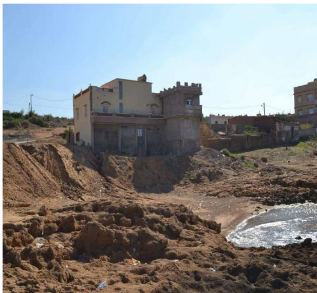
Figure144:photo d'une habitation achevée
