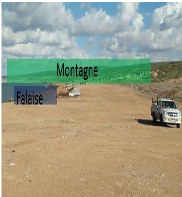
Figure152:photo de constat Source Auteur 2018
