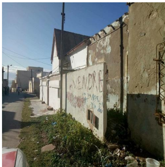
Figure143:photo d'une habitation achevée
