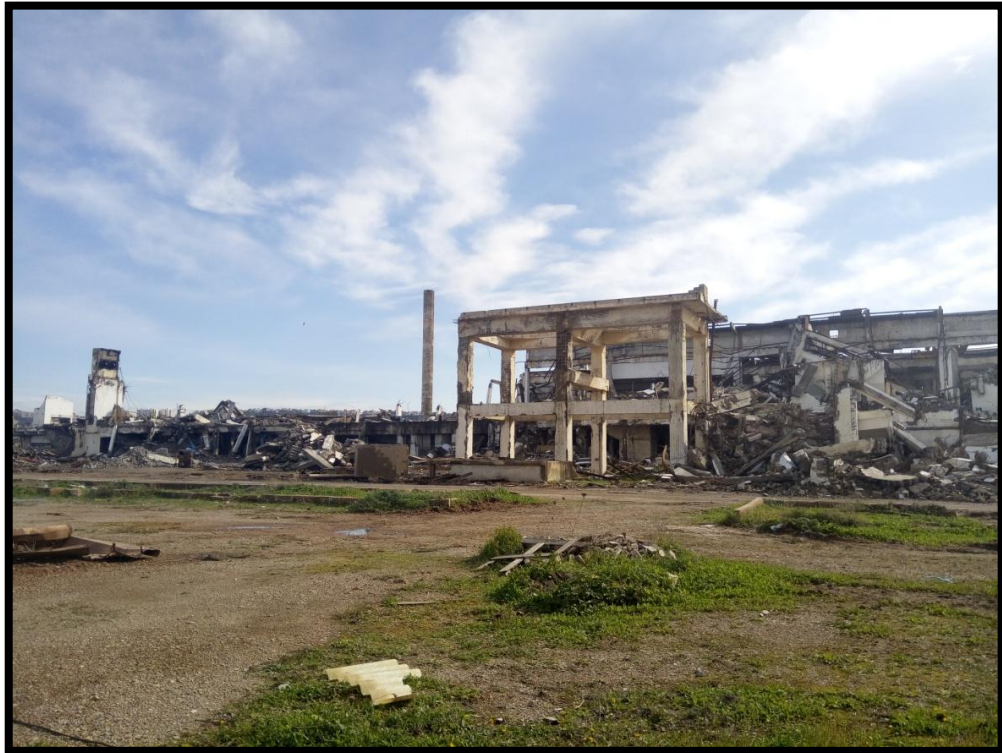
Figure 3 : les travaux de démolition sur la zone , prise par trinôme
