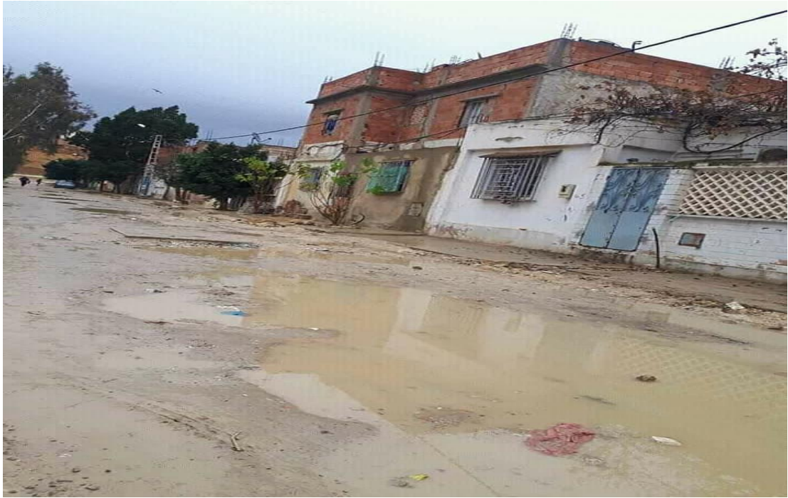
Figure 32 : séquence sur des travaux non complets dans le quartier de la ville
