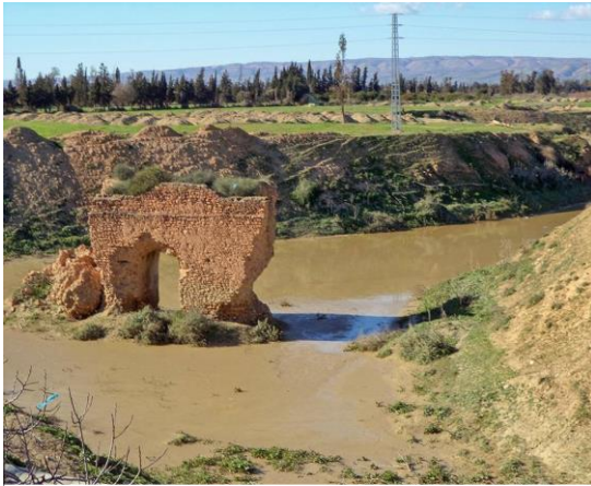
Figure 29 : séquence d'ancien pont à l'entrée de Relizane, traversant Oued
