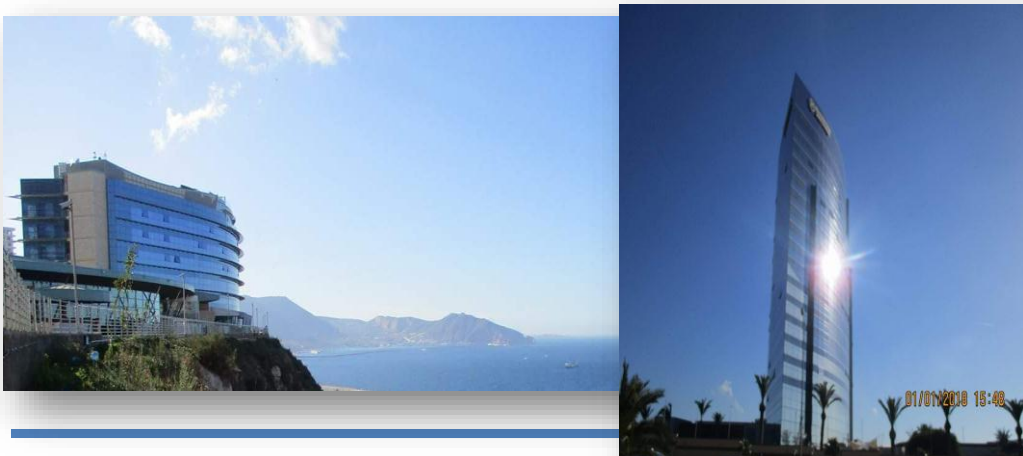
Figure 44: Les deux hôtels ; Sheraton et four point
