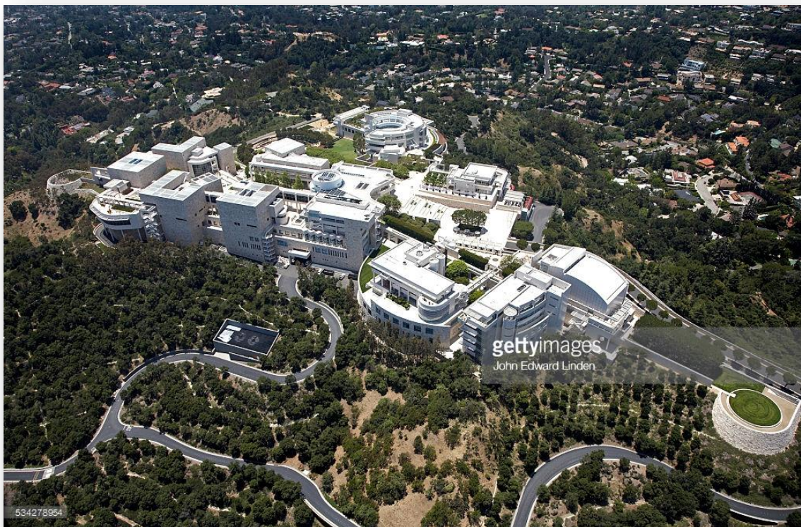
Figure 53: vue de Getty center
