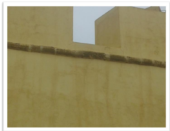
Vue de l'extérieur
