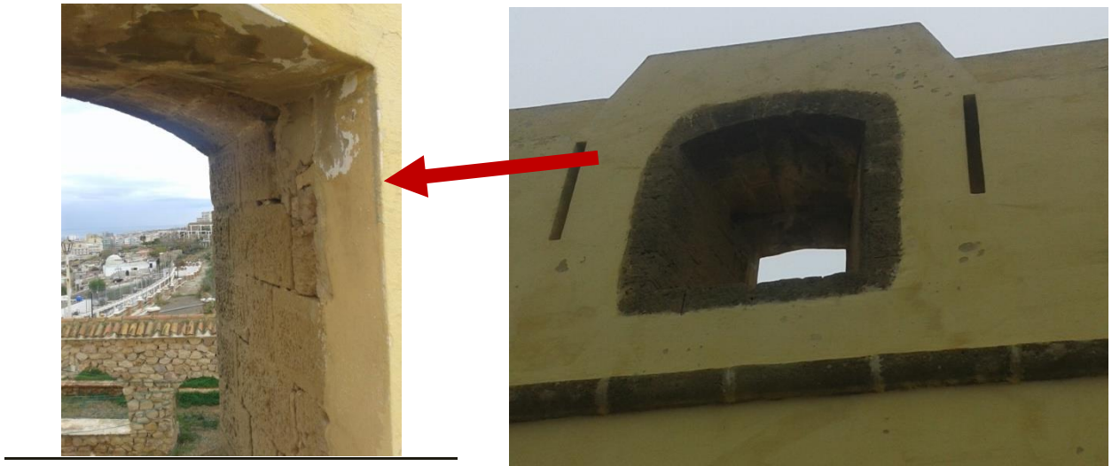
Figure : Ouverture dans le mur de terrasse
