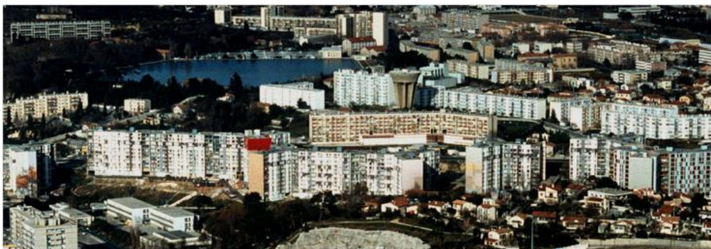
Le quartier du flamant, vue du sud
