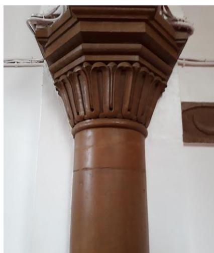
Figure152: Colonne engagée à  $\frac{3}{4}$ (aux angles)
