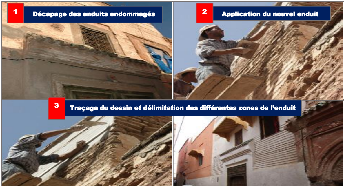
Figure 29 : restauration des façades
