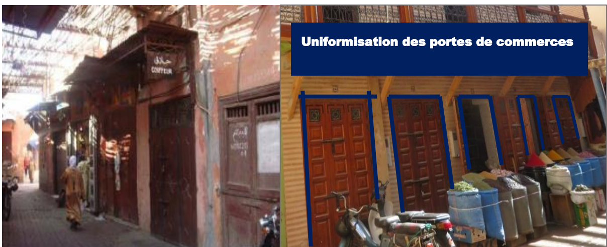
Figure 26 : réhabilitation des façades
