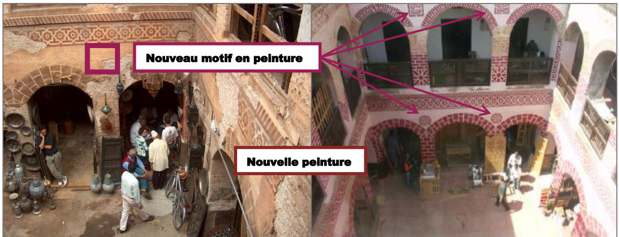
Figure 27 : Restauration de fondouk Alamri
