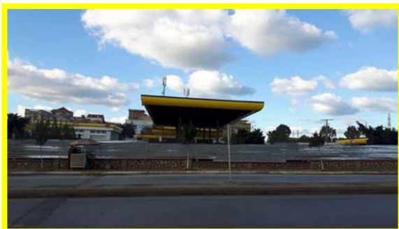
FIGURE 4.13: Station d'essence . SOURCE Auteurs de mémoire.
