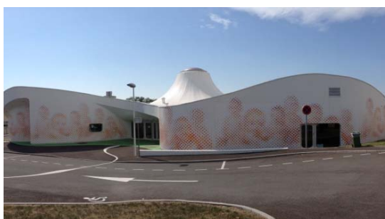
FIGURE 3.17: façade est de crèche SOURCE : allocreche.fr/57/piblange/mairie-bt6
