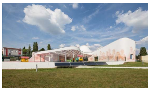
FIGURE 3.18: façade ouest de crèche SOURCE : allocreche.fr/57/piblange/mairie-bt6
