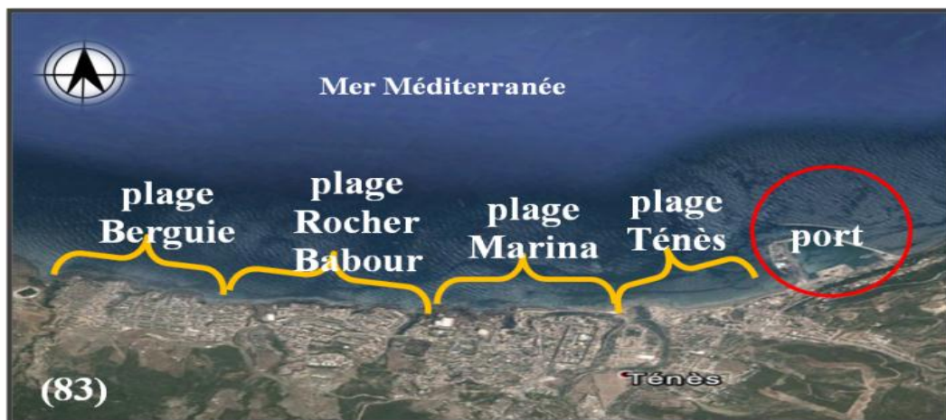
Figure(83) constat général, plages de la ville de Ténès.
