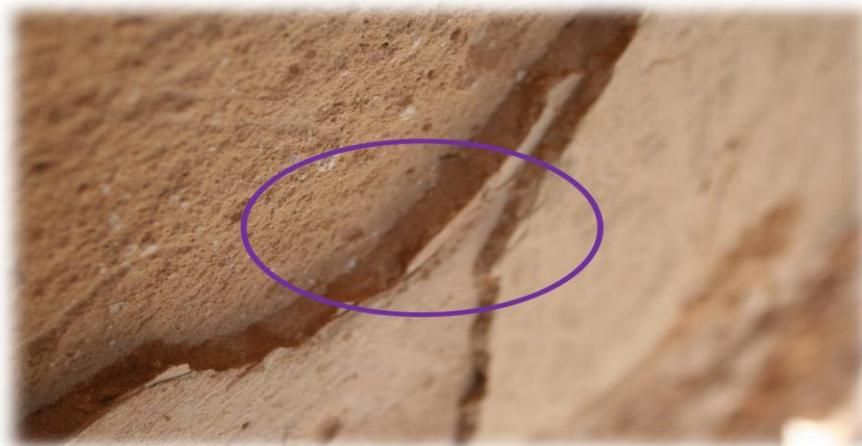
Figure 147 : les différentes couches du mur d'intérieur de l'édifice de Sfisifa khadra
