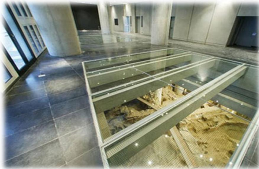
**Figure 52 : Rampe en verre transparent sur les fouilles**
