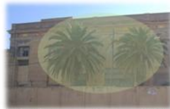
Palmier, Photo de constat ,auteurs, 12/2015.
