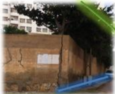
Arbres, photo de constat 12/2015
