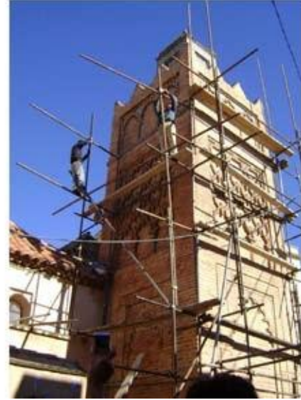
Restauration de la mosquée de Sidi-belahcen
