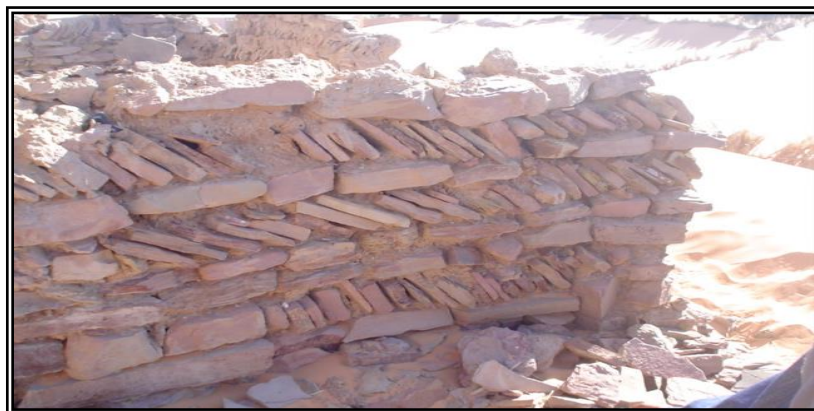
Photo N° 40 : Le mur d'enceinte en pisé
