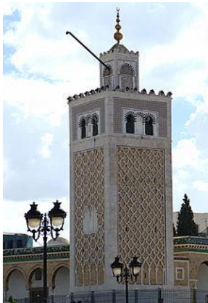
Fig II.13 Minaret du Mosquée el Quasba Tunisie , Source : www.meteocity.com
