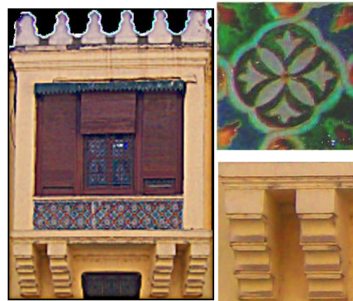
Fig III.7 Décomposition des composantes du moucharabieh Source : auteur de mémoire
