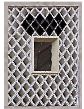
Détail des loggias-balcons-la Tourette-Marseille Source : www.fernandpouillon.com
