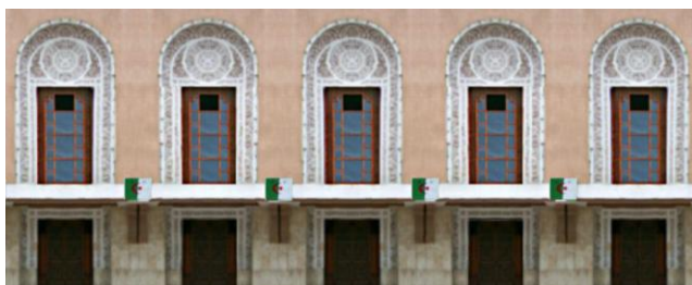
Fig III.19 Accès principale de la gare
