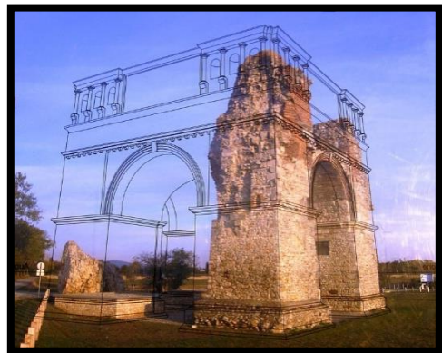
Figure 2 En cours de restauration
