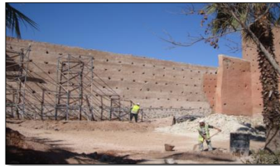
Figure . 98 Travaux de restauration de la muraille.
