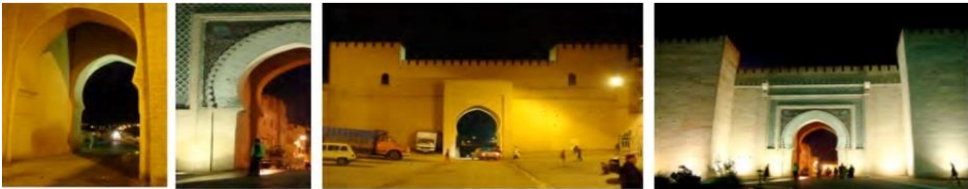
Figure. 111. Muraille et portes après la restauration.
