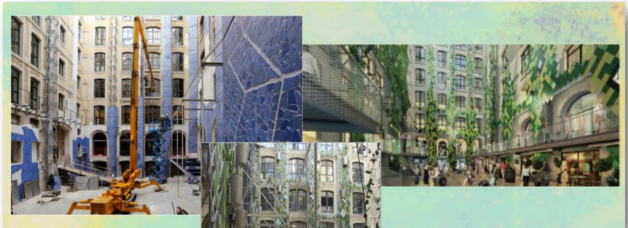
Photo 1 : les travaux de réhabilitation des docks
