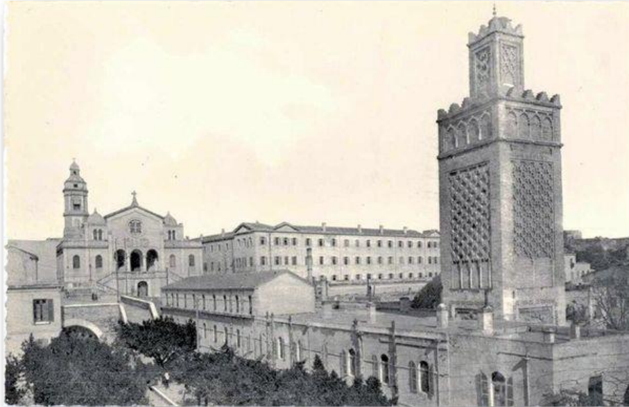
Photo 7 : En avant plan la mosquée de Sidi El Houari et de l'ancien hôpital militaire dit « de la mosquée » Source : Paul Ruff, « La domination espagnole à Oran sous le gouvernement du comte d'Alcaudete », Paris, 1900
