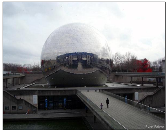
Fig. 52 : Pont joignant la Géode
