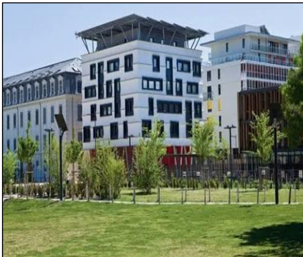
Fig. 30 : Bâtiment de bureaux
