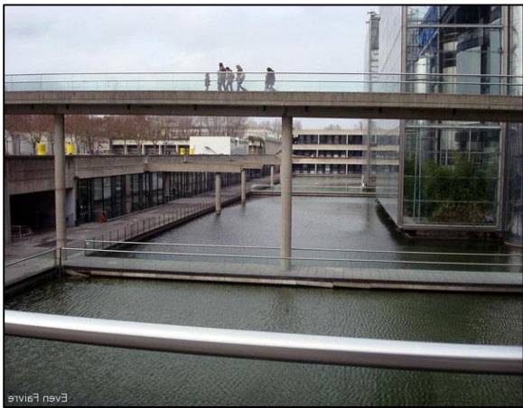
Fig. 53 : Pont joignant la Géode
