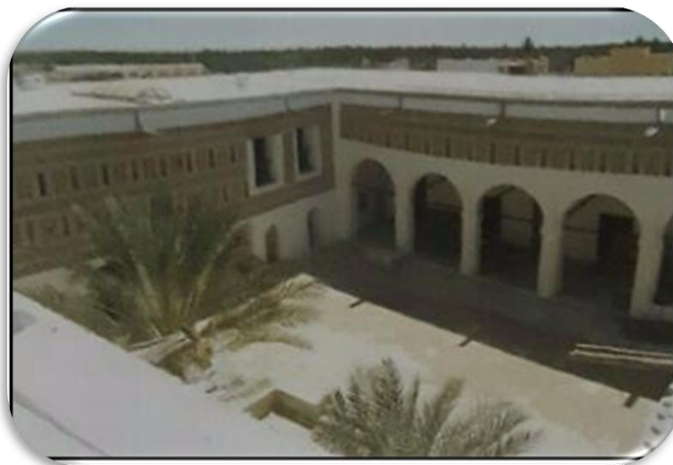
Figure IV-5 ; Vue dar El Wadi après la restauration
