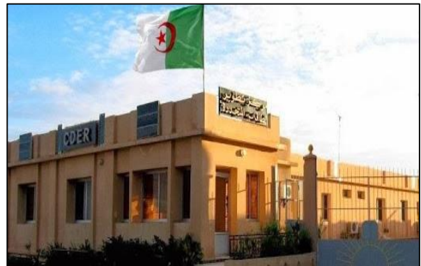
Fig. 74 : Centre de Développement des Energies Renouvelables CDER
