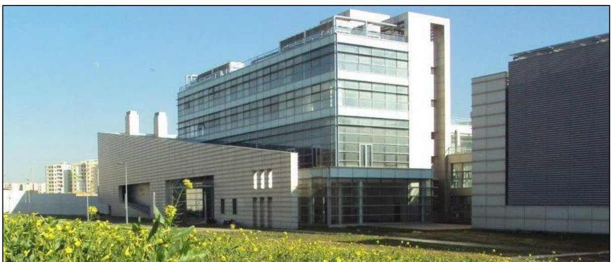
Fig. 31 : le bâtiment de CDS.
