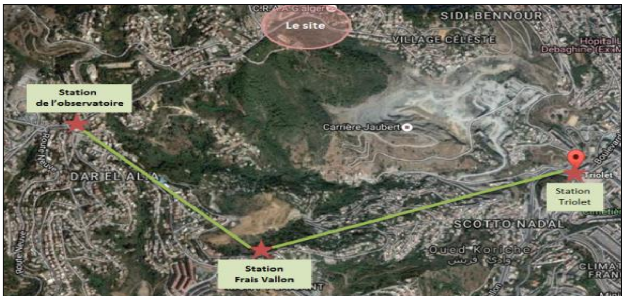
Fig. 70 : la ligne de téléphérique de Bouzareah
