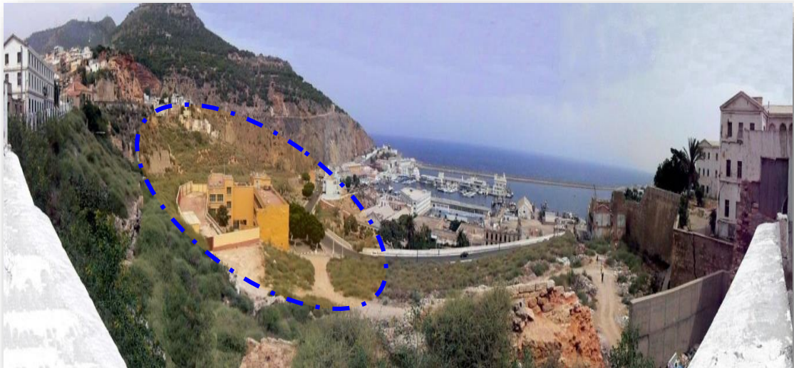
Fig01. Vue panoramique sur le site d'intervention
