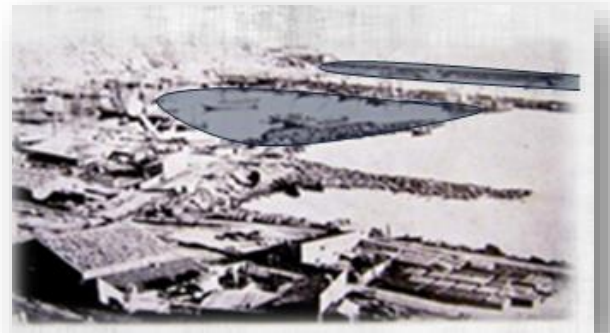
Fig46. Construction du vieux -port
