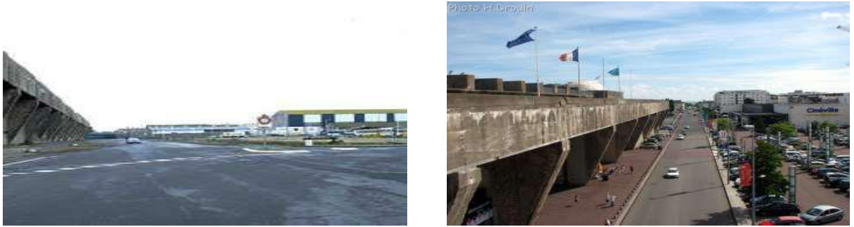
Fig32. Boulevard de la Légion d'Honneur requalifié dans le cadre du projet Ville-Port .
