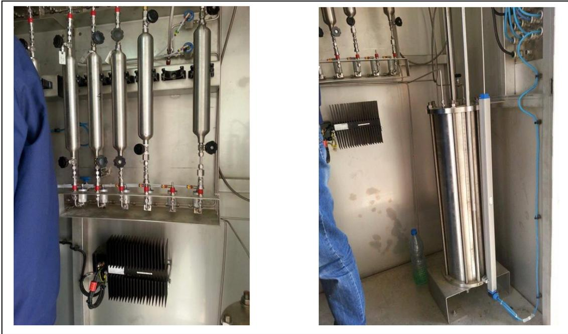
Figure 19.1. System d'échantillonnage de GNL en mode continue.
