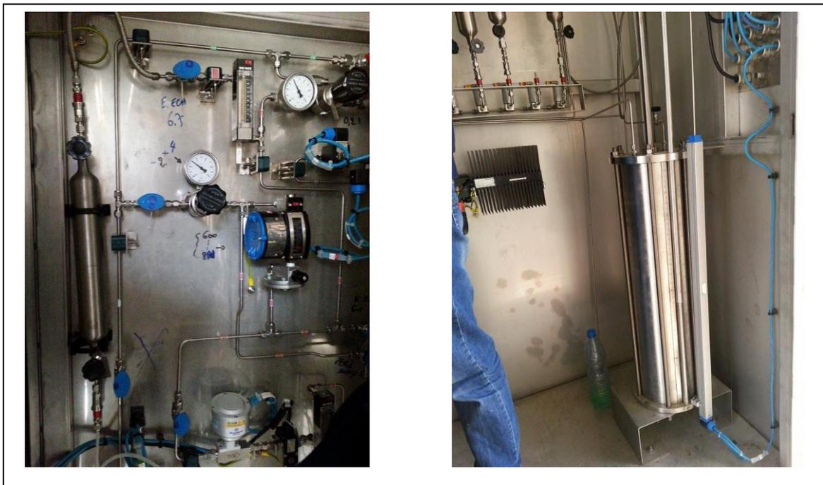
Figure 19.2. System d'échantillonnage de GNL en mode discontinue.
