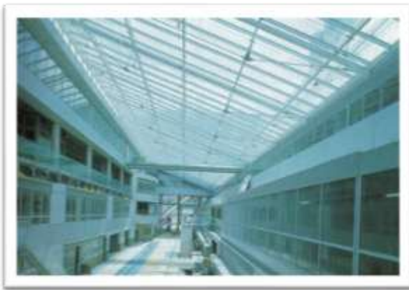
Figure 66 : la rue intérieure
