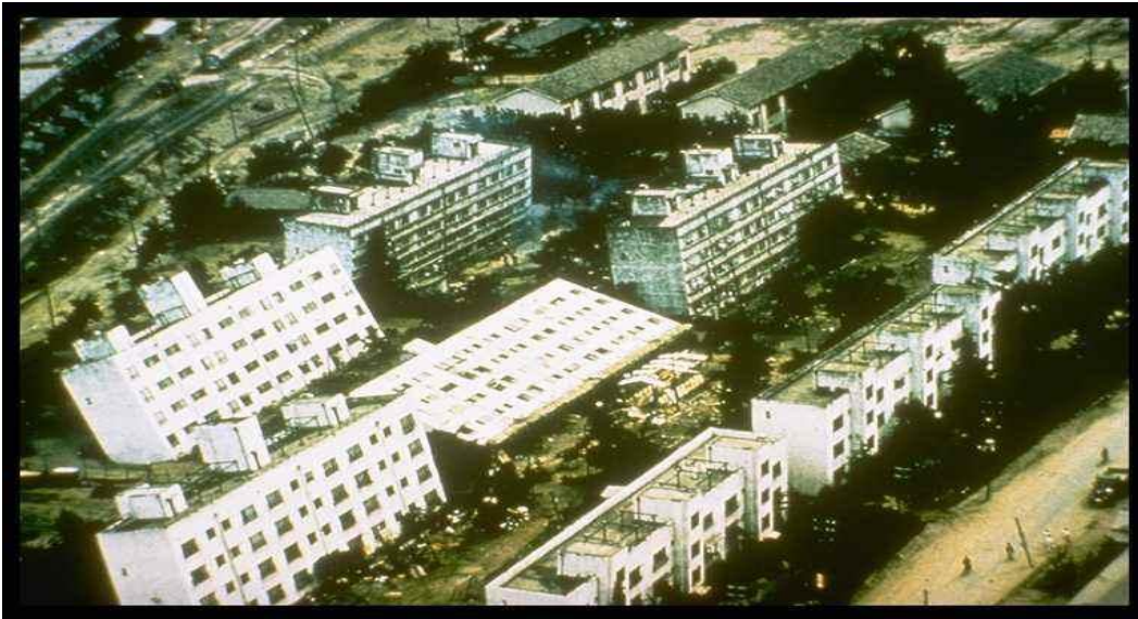
Figure 1.1 : Enfoncement, basculement et renversement des bâtiments lors du séisme de Niigata Japon (1964)
