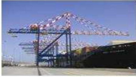
A : grue de quai.
