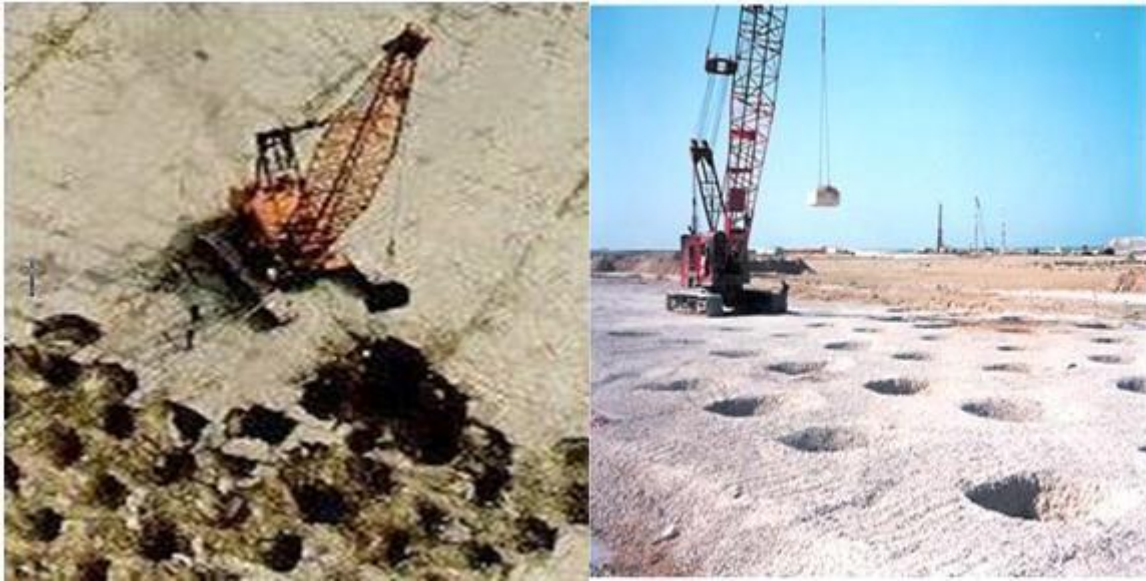
Figure (I.7) : technique de compactage dynamique.
