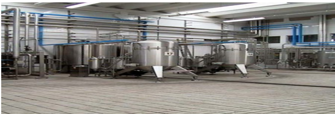
Figure (II.1) : les colonnes de la décoloration.
