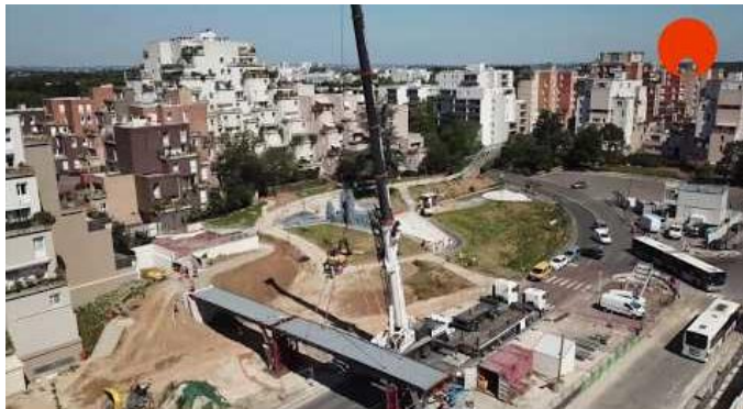
Figure 11 Installation de la passerelle Place des Miroirs
