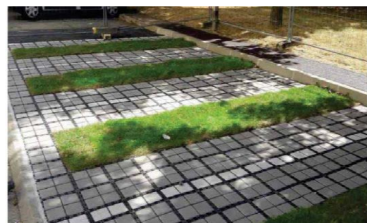
Figure 46 : Prototype éco-végétal en phase d'installation - juillet 2020
