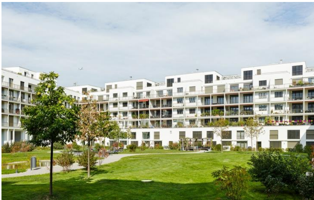
Figure 46 Richti Areal, cour d'immeuble de logement
