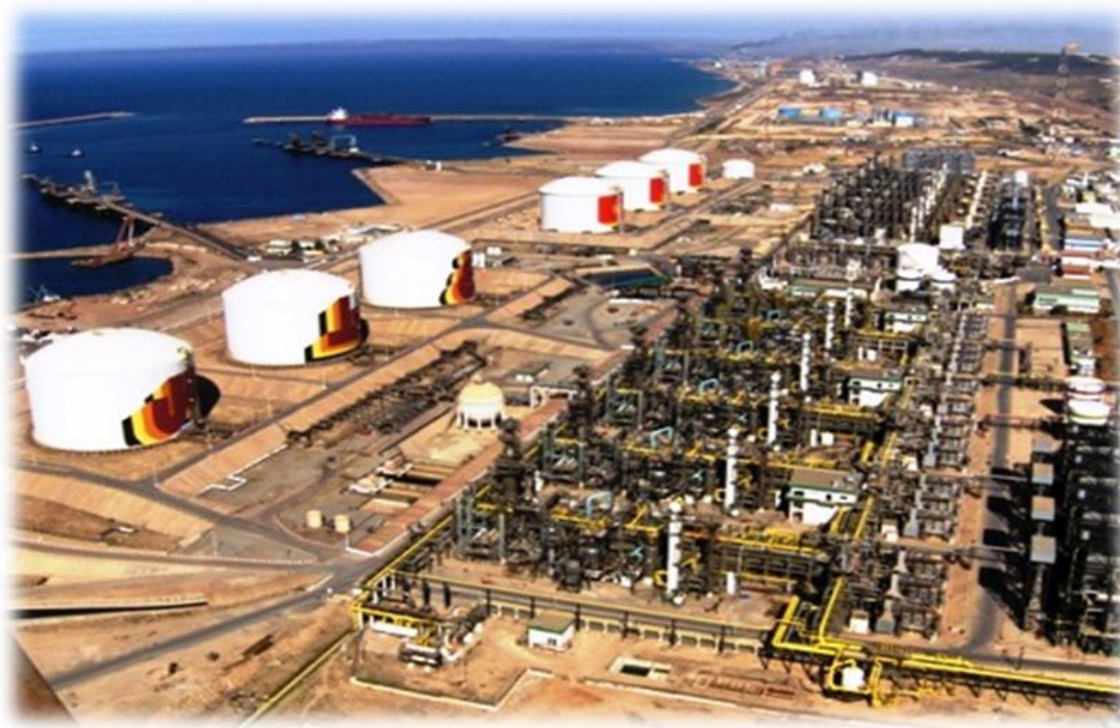
Figure 10 : Usine de liquéfaction de gaz naturel [12].
