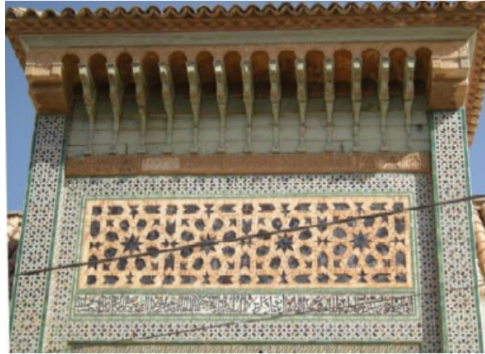
الصورة 70: ظلة بوابة مسجد سيدي الحلوي
