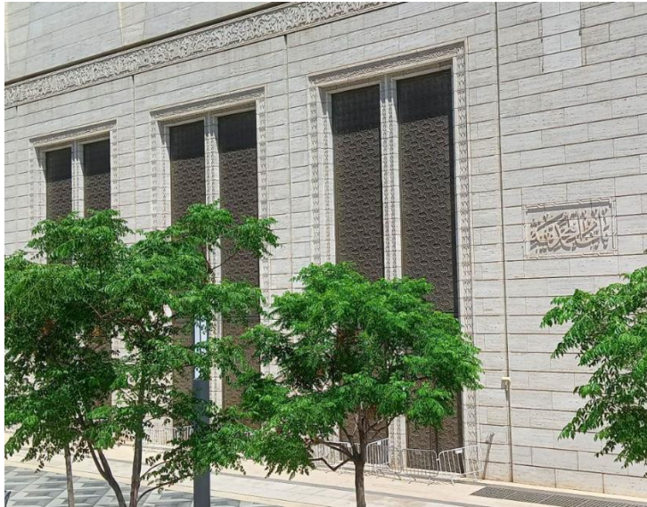
الصورة 23: المدخل الرئيسي الجنوبي لقاعة الصلاة "باب المحمدية"
