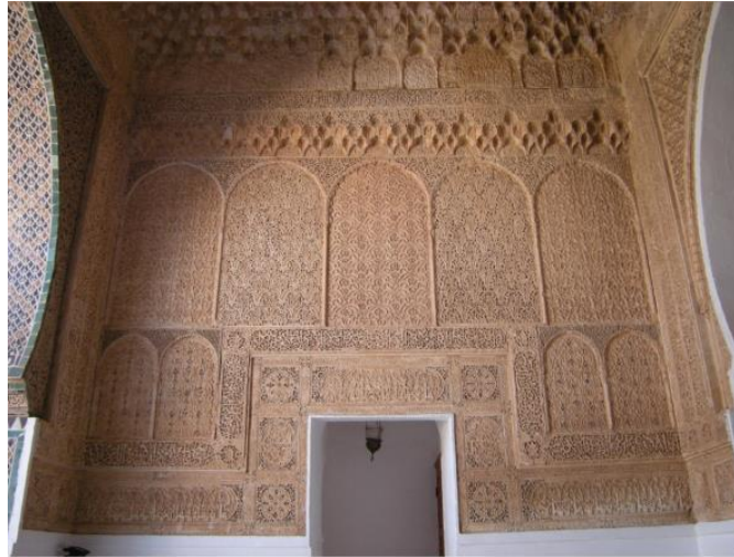
الصورة 49: الجدار الشرقي لبهو لبوابة مسجد سيدي أبو مدين
