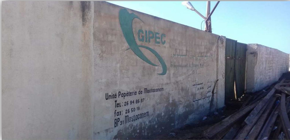
Figure16 : Photo de constat, l'entrée de l'usine GIPEC
