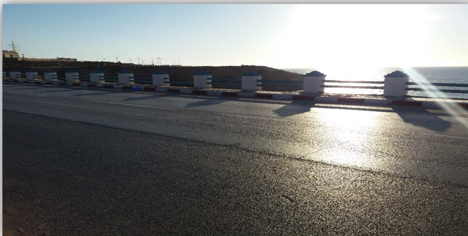
Figure15 : Photo de constat, la voie mécanique
