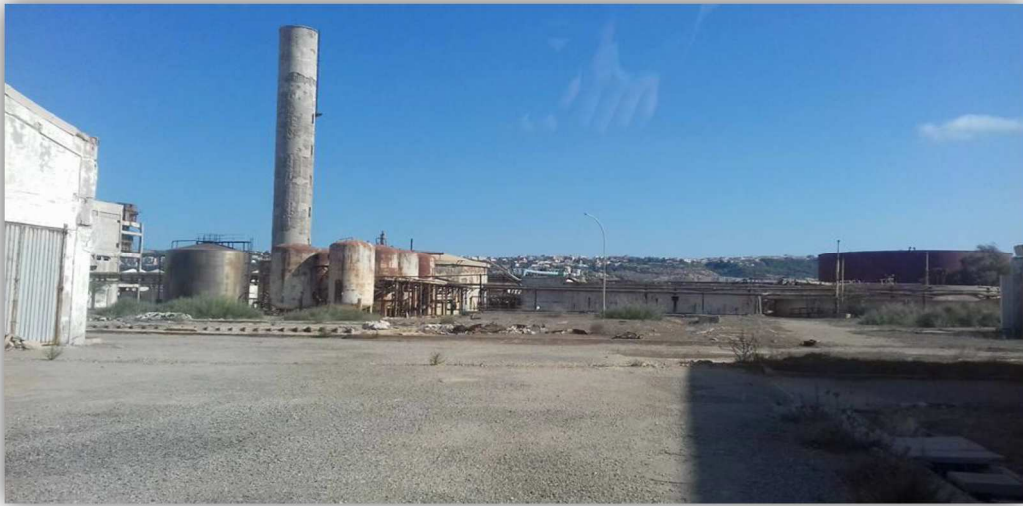
Figure17 : Photo de constat, le château d'eau de l'usine
