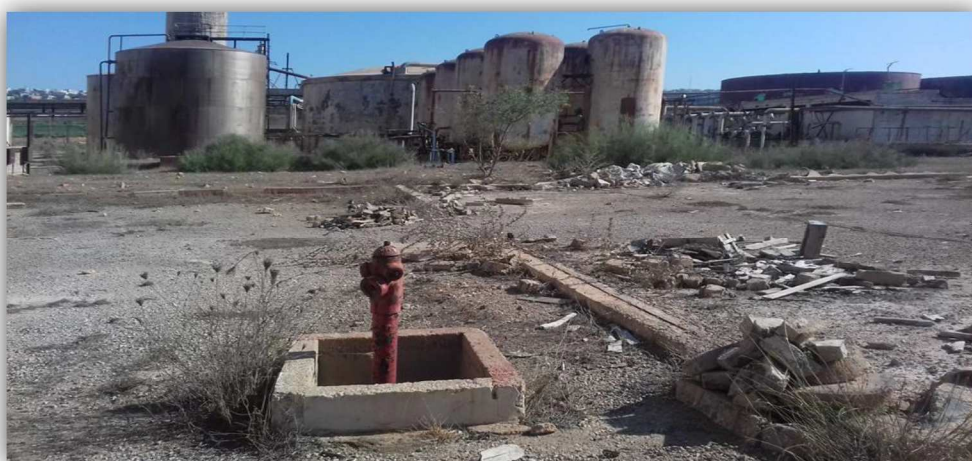
Figure20 : Photo de constat, l'état actuel de l'usine à l'intérieur
