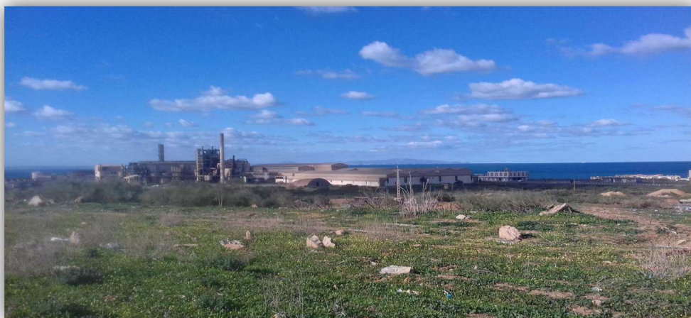
Figure19 : Photo de constat, vue d'ensemble de l'usine
