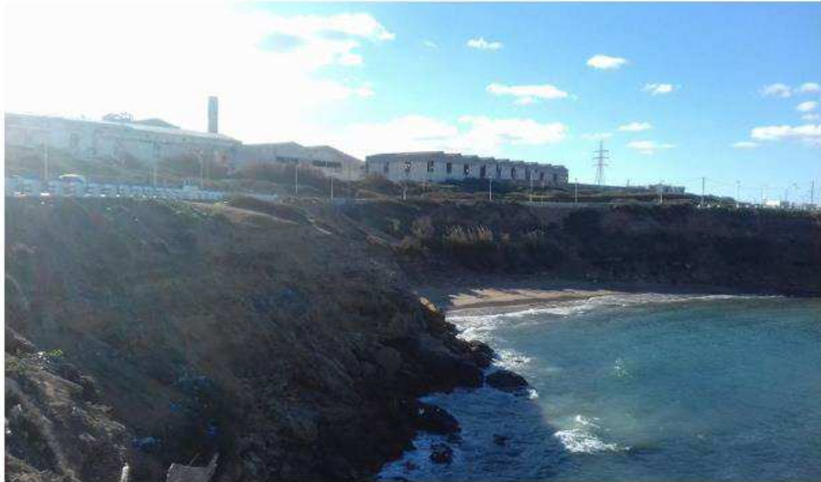
Figure 51 : Photo de constat, la plage de la crique, auteur 18\10\2017
