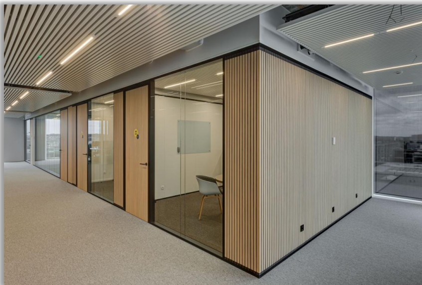
Figure 35: Cloisons intérieures – Système modulaire
