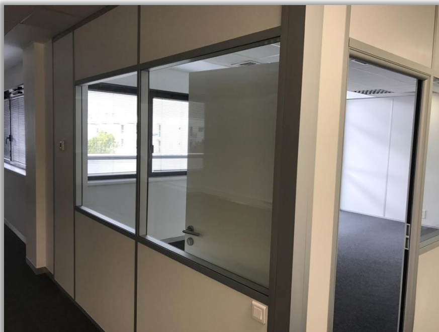
Figure 34: Cloisons intérieures – Système modulaire
