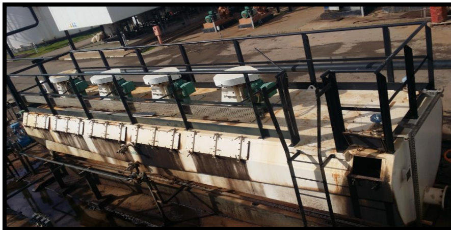
Figure I-5 : système de flottation IGF
