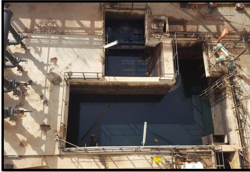
Figure I-2 deversoir et bassin d'orage
