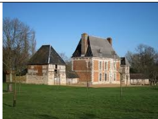
Figure I.39: vue d'angle du clos
