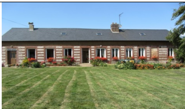
Figure I.38: façade de l'habitation du clos
