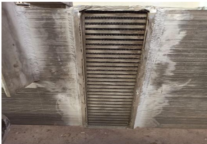
Figure I.10 : Échangeur à plaque (département inspection de GL2/Z) [5]
