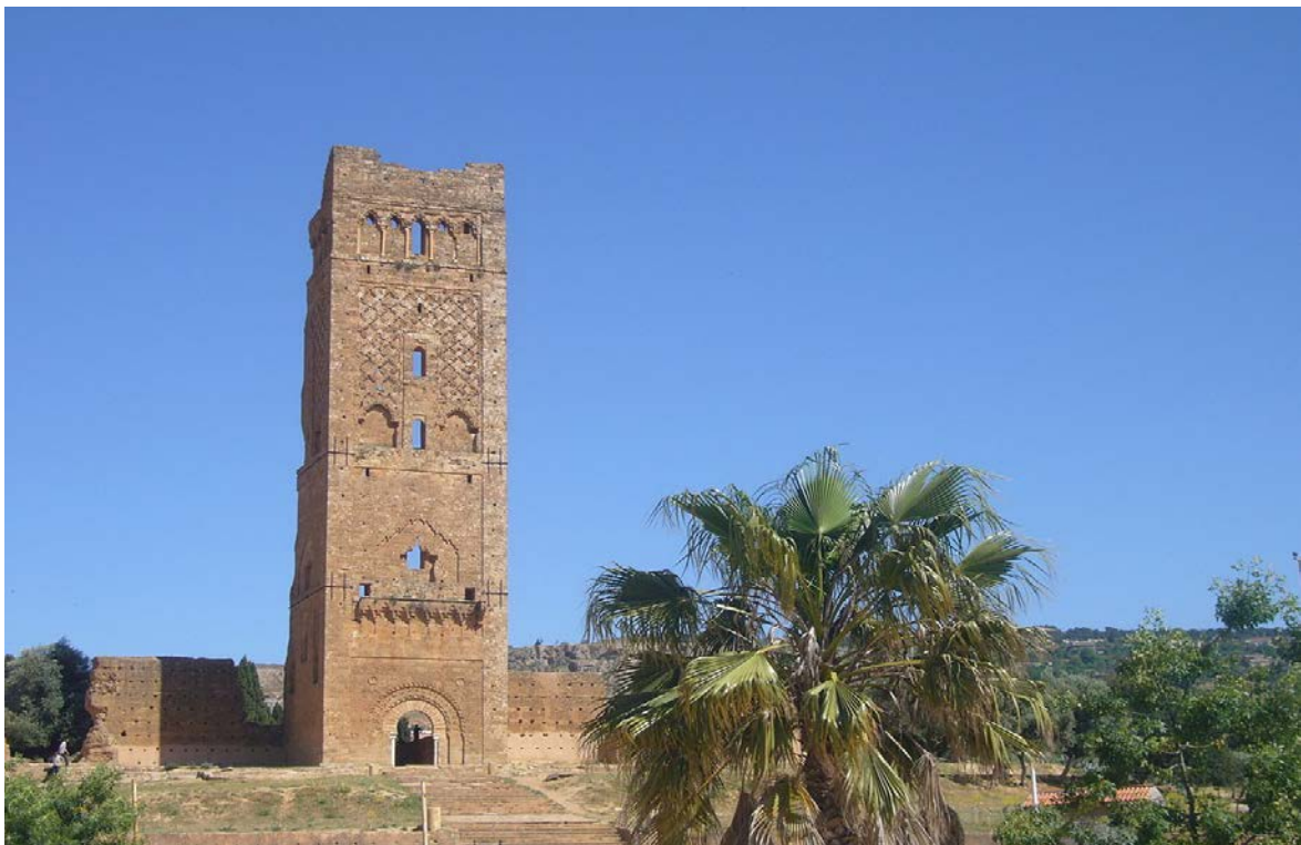
الملحق (18): مسجد المنصور في تلمسان
