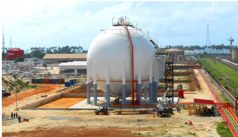
Figures 2.3 : Stockage sphérique.
