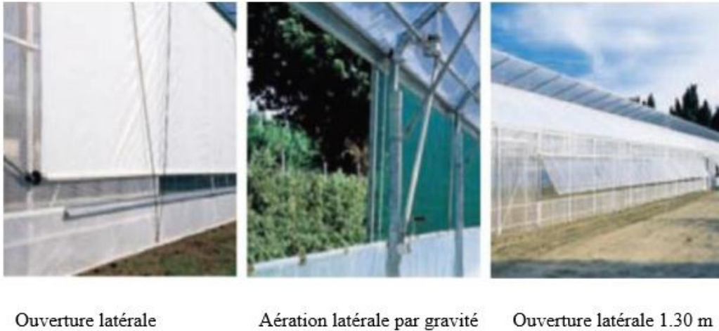
Figure I-4 : Les différents modes d'aération latérale des serres.
