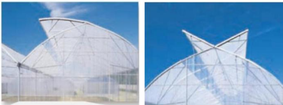
Figure I-5 : Aération double versants.
