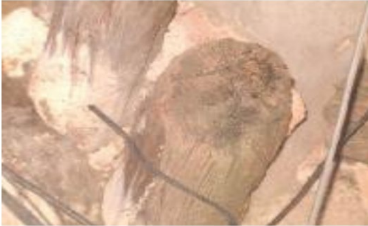
Figure 43 : Moisissure du bois Fonction de son taux d'humidité. source ( site web info sinistar )
