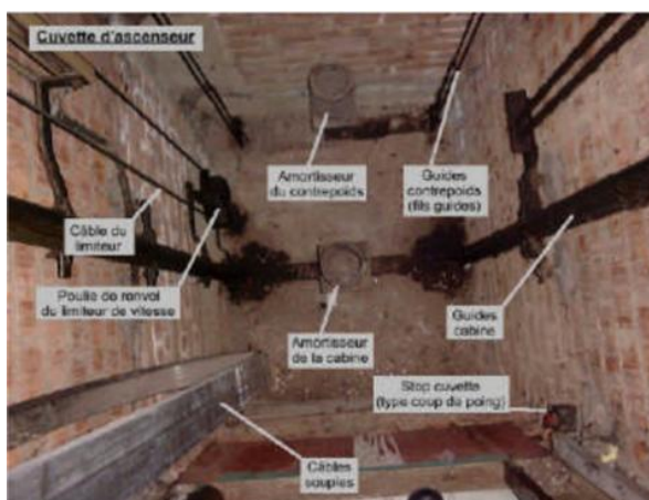
Figure I- 6 : Cuvette d'ascenseur.
