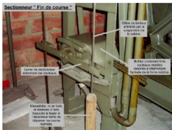
Figure I- 7 : Fin de course ou sectionneur.
