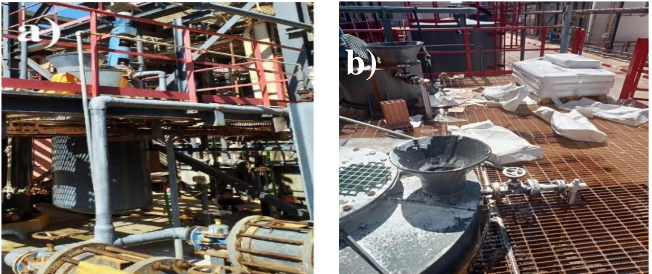
Figure II.10 : La filtration : (a)les deux filtres F-111A et F-111B, (b) L'entrée de cellulose.
