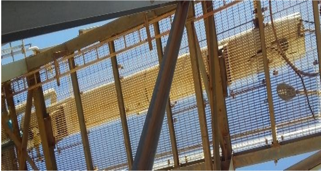
Figure II.18 : Echangeur de chaleur tubulaire à calandre HE-162.
