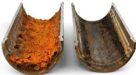
Figure IV.1 : corrosion sous dépôt
