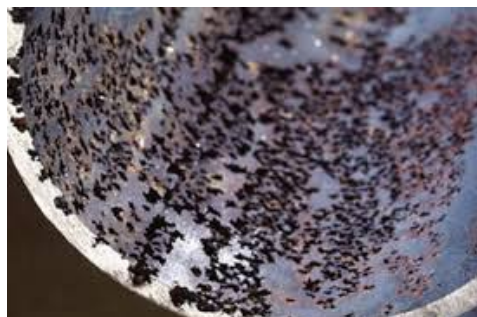
Figure IV.5 : corrosion par érosion
